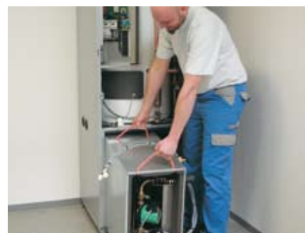
Encastrer le modulbox dans l'appareil.
