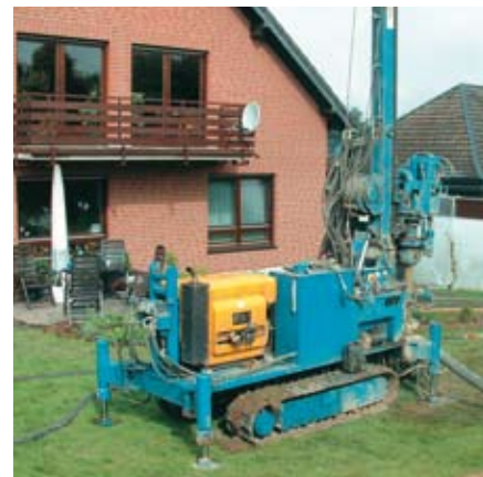
Forage pour la sonde géothermique
