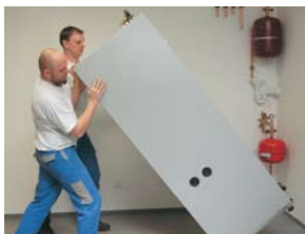
Basculer la pompe à chaleur et la poser à sa place.
