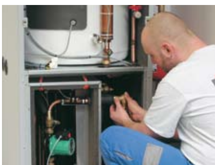
Raccorder le modulbox.
