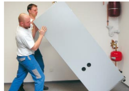
Basculer la pompe à chaleur et la poser à sa place.
