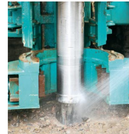
Forage pour la sonde géothermique
